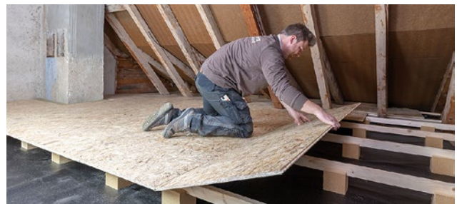
Verlegen des Bodenbelags
