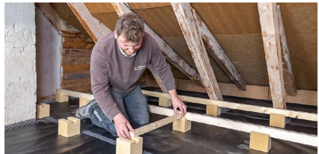
Ausrichten der Dämmfüße mit einer Abstandhilfe
