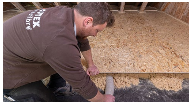
Verfüllen mit GUTEX Thermofibre Einblasdämmung
