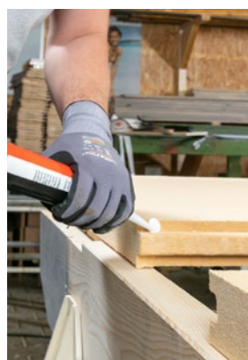
Stoßdetail/-abdichtung bei Dachelementen mit GUTEX Prefatop (Detail 1.1.601)
